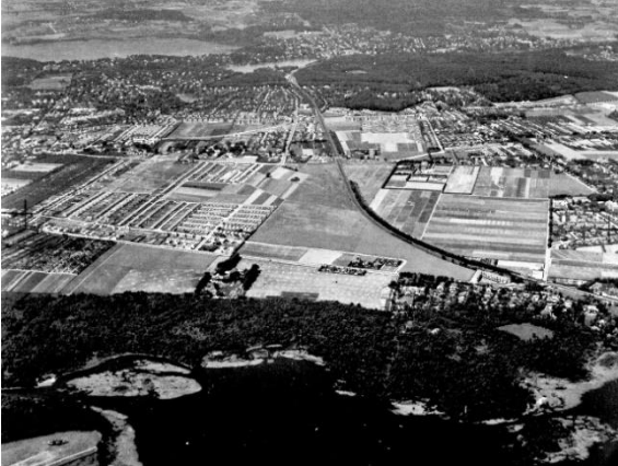
Sorgenfri 1949, nederst Lyngby Sø og Lyngby Åmose. Nord for tegner jernbanen sig som en mørk linje i retning mod Virum. De første villaer og rækkehuse er opført.
